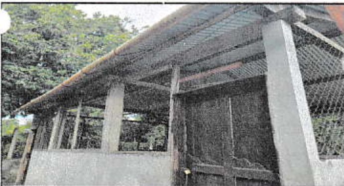
Foto 5: Parales que sostienen la malla de las ventanas de la cocina se encuentran podridas.
